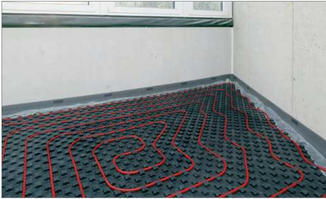
Εικ. 3-11 Σύστημα πλάκας κόμβων Varionona με ηχομόνωση κτυπογενών ήχων 30-2 στην κάτω πλευρά
