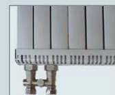
Σύνδεση στο κάτω μέρος του σώματος
